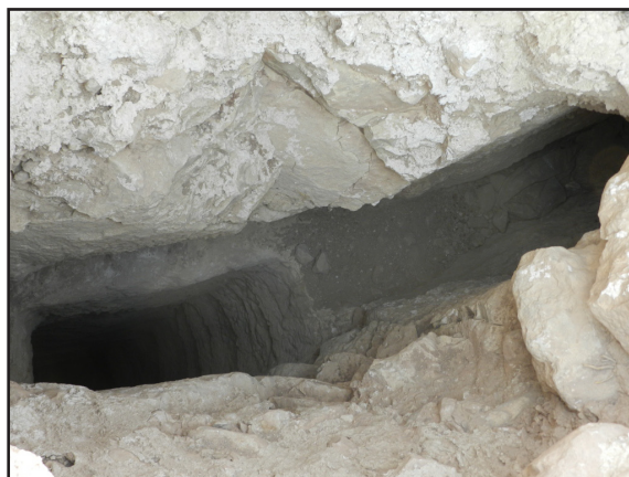
تصویر ۴. یکی از میله‌های قنات چال کفتاری در دره لهراسب (عکس از: نگارندگان).
